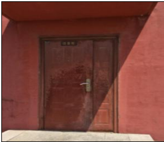
图 10 一楼仓库门(进入暂存库门)
