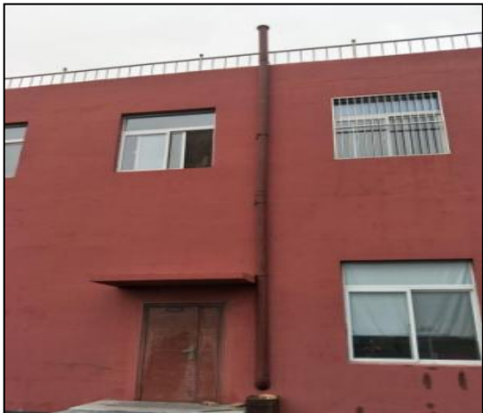
图 13 室外通风排口
